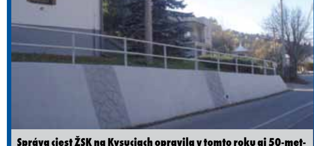
Správa ciest ŽSK na Kysuciach opravila v tomto roku aj 50-metrový oporný múr v Zákopči.
