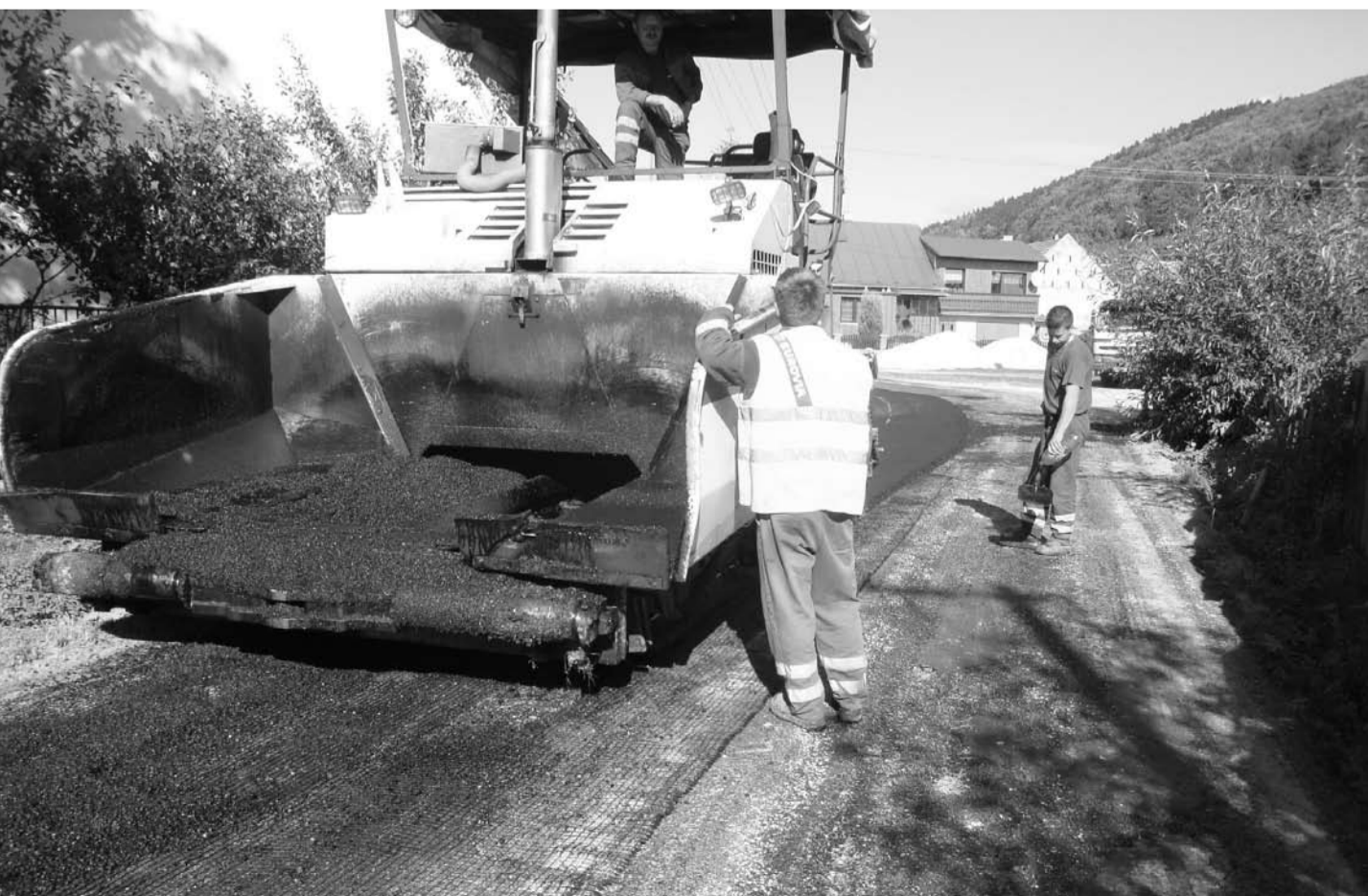
Malá Čierna - Rajec. Úsek sa zrekonštruoval v rámci I. kola ROP.
