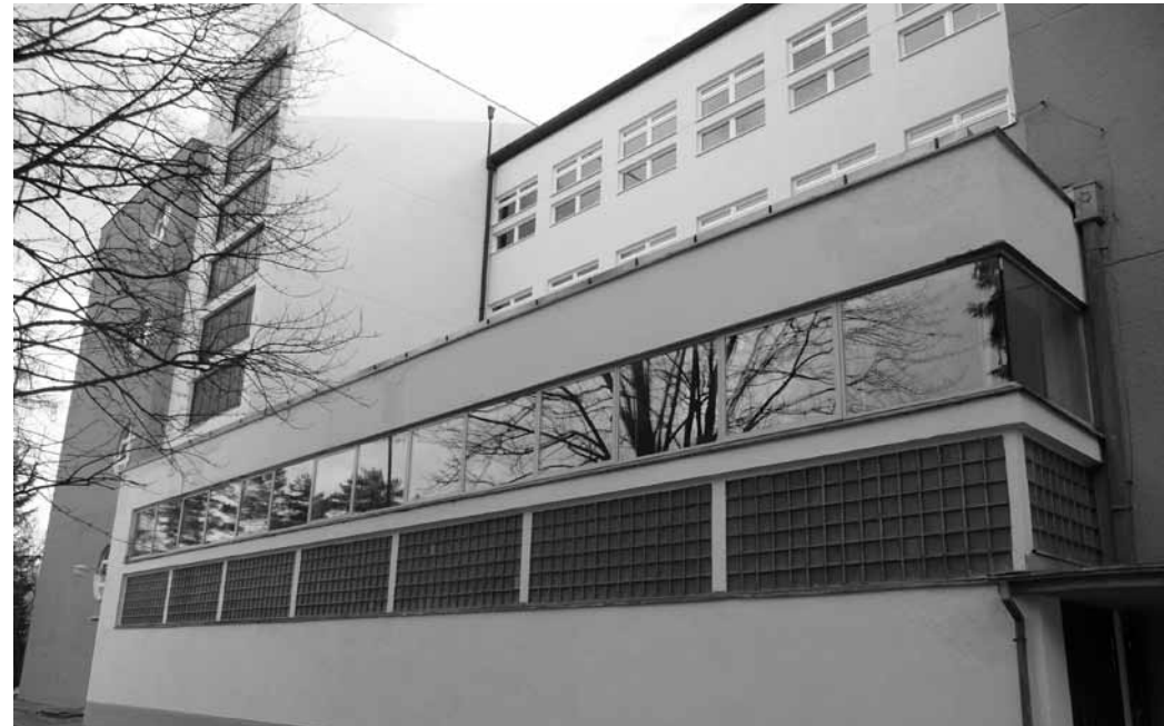
Gymnázium Viliama Paulinyho - Tótha v Martine Prešlo komplexnou rekonštrukciou.
