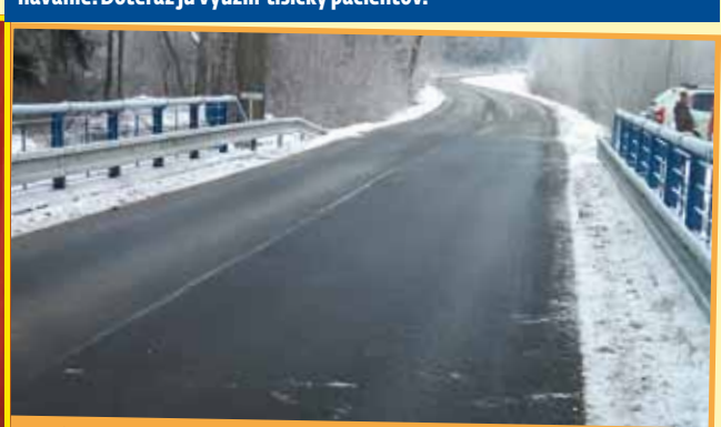
V Kláštore pod Znievom župa opravila most. Investícia dosiahla takmer 84-tisíc eur.
